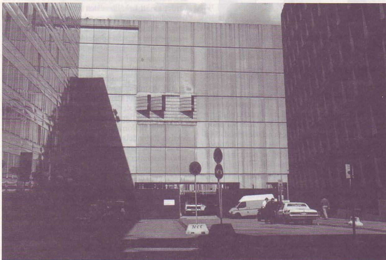
Baksidan av Kulturhuset
